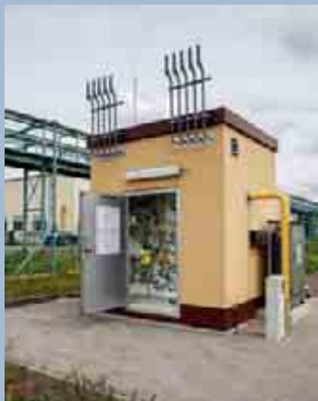
In dem kleinen Häusschen befinden sich hinter der offenen Tür die Gasdruckregel- und Messanlage, rechts daneben im schwarzen Kasten die Odorieranlage und im hinteren Teil die Verbindung zur zentralen Leitstelle (Bild: HTWK Leipzig)
