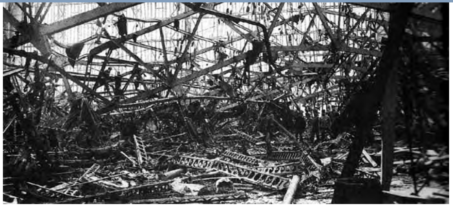
Luftschiffhalle in Leipzig-Lindenthal nach Einsturz am 8. Februar 1917. Fotos: Archiv Autor
