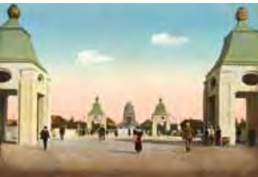
IBA 1913: Brücke in der Hauptallee
