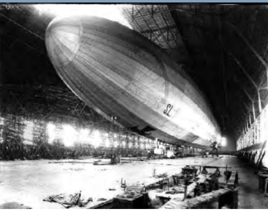
Luftschiffhalle in L.-Lindenthal 1916 -17. Luftschiff SL 13 fast fertig und links SL 18 in Bau
