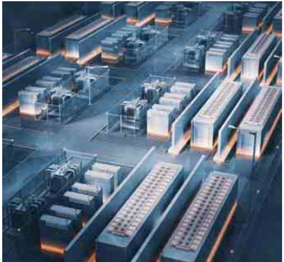
13 Container werden die Lithium-Ionen-Batterien beherbergen, die künftig dabei helfen sollen, das Stromnetz gegen Schwankungen abzusichern. (Grafik: LEAG)
