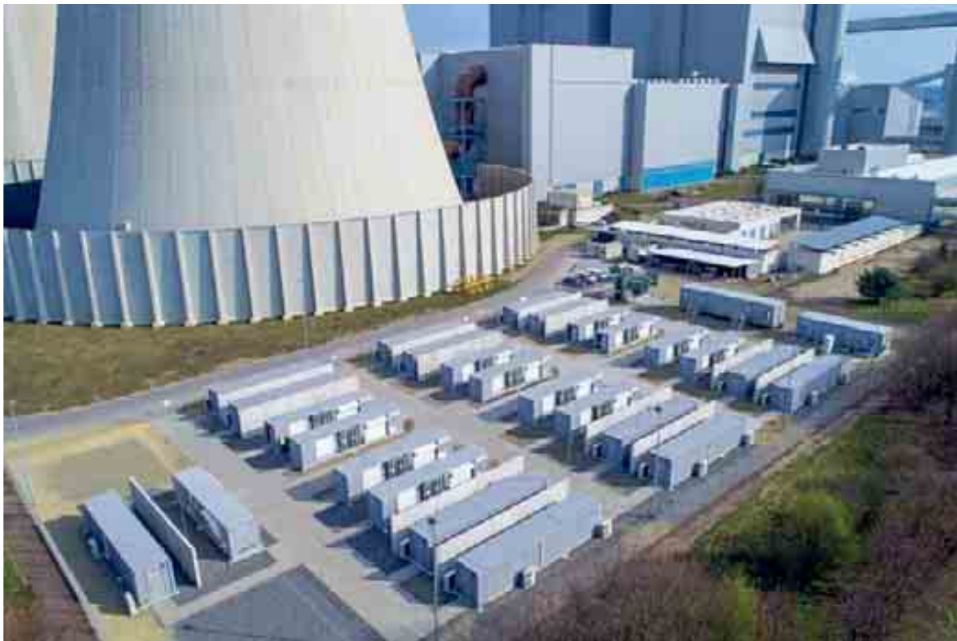
Der Batteriespeicher BigBattery gleicht kurzfristig Schwankungen in der Stromversorgung aus.
