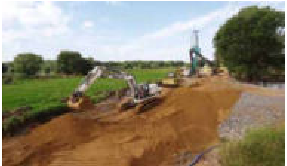
Sofortsicherung eines Deichbruches bei Hohenprießnitz im Juli 2013
