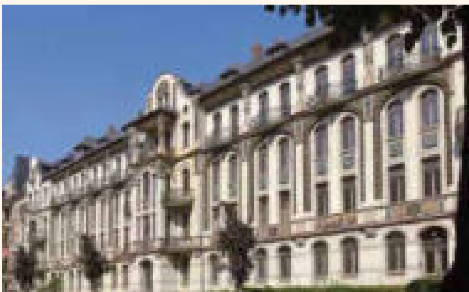
Majolika-Fassade in Gründerzeitviertel Kaßberg (Foto: Ulf Dahl / Stadt Chemnitz)
