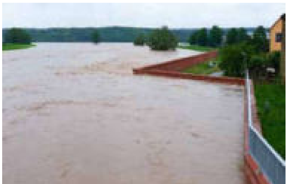
Neue Hochwasserschutz-Mauer in Sermuth an der Zwickauer Mulde im Juni 2013 zum Höchstwasserstand
