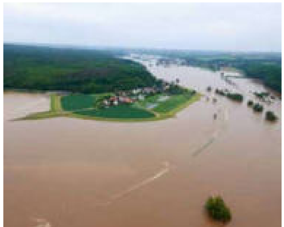
Neuer Hochwasserschutzdeich Erlln an der Freiburger Mulde
