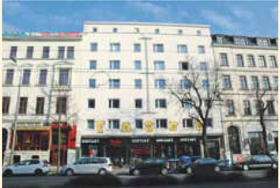
Haus in der Karl-Liebnechtstraße mit Photokatalytische Fassadenbeschichtung und Messgerät
