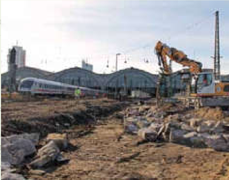
Bauarbeiten im Vorfeld des Leipziger Hauptbahnhofes/ Foto: Frank Kniestedt
