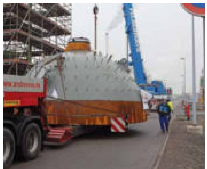
Die tonnenschwere Kuppel für den Regenerator im Cracker wurde in der Raffinerie komplettiert. Fotos: TOTAL
