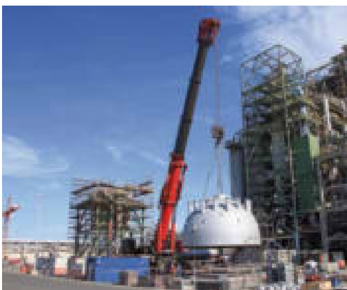
Die tonnenschwere Kuppel für den Regenerator im Cracker wurde in der Raffinerie komplettiert. Fotos: TOTAL
