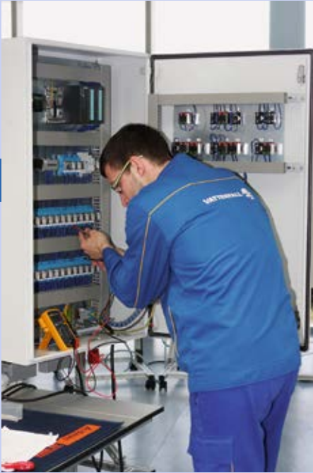
Elektroniker für Betriebstechnik im 3. Lehrjahr nimmt im Rahmen einer Projektarbeit den Schaltschrank unter 400 Volt Drei-Phasen-Wechselspannung, in Betrieb Fotos: Archiv Vattenfall
