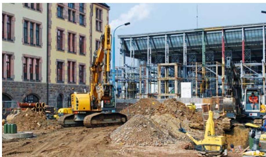
Um eine Durchbildung der Straßenbahnlinien zu ermöglichen, waren auch umfassende Baumaßnahmen am Chemnitzer Hauptbahnhof Bestandteil der Stufe 1 des Chemnitzer Modells. Alle Fotos: VMS
