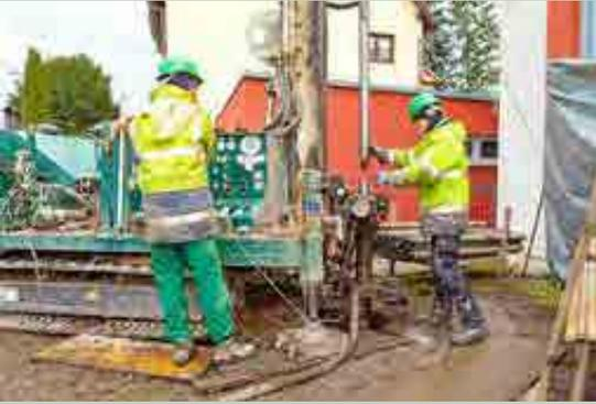
Wer in die Tiefe will, braucht schweres Gerät: Spezialtiefbauer der Firma SBS bohren auf dem Grundstück eines Architekturbüros in Markkleeberg, um eine Erdwärmesonde zu installieren (Foto: Swen Reichhold / HTWK Leipzig)
