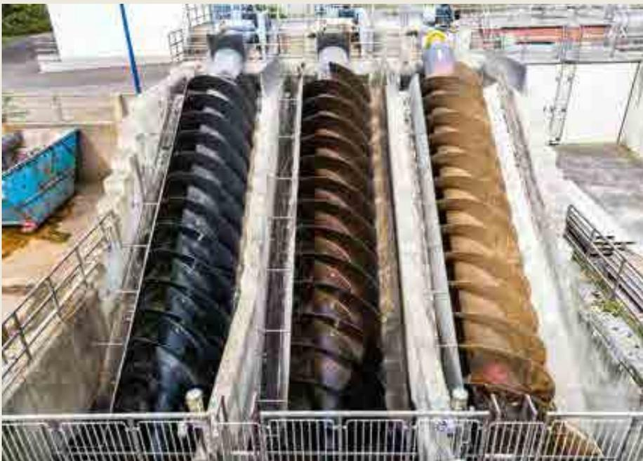
Hebwerk (Mechanische Reinigung): Das Abwasser hat jetzt den tiefsten Punkt des Klärwerkes erreicht. Mit den Schneckenpumpen des Hebwerkes wird es auf eine fünf Meter höhere Ebene transportiert. Nach dem Anheben gelangt das Abwasser im freien Gefälle zur Vorklärung.
