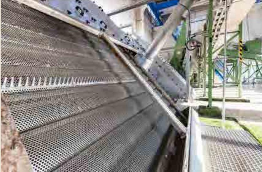
Filterbandrechen: Die Rechenanlage ist die erste Stufe der mechanischen Reinigung. Hier werden im Abwasser mitgeführte Grobstoffe von vier Filterbandrechen zurückgehalten.
